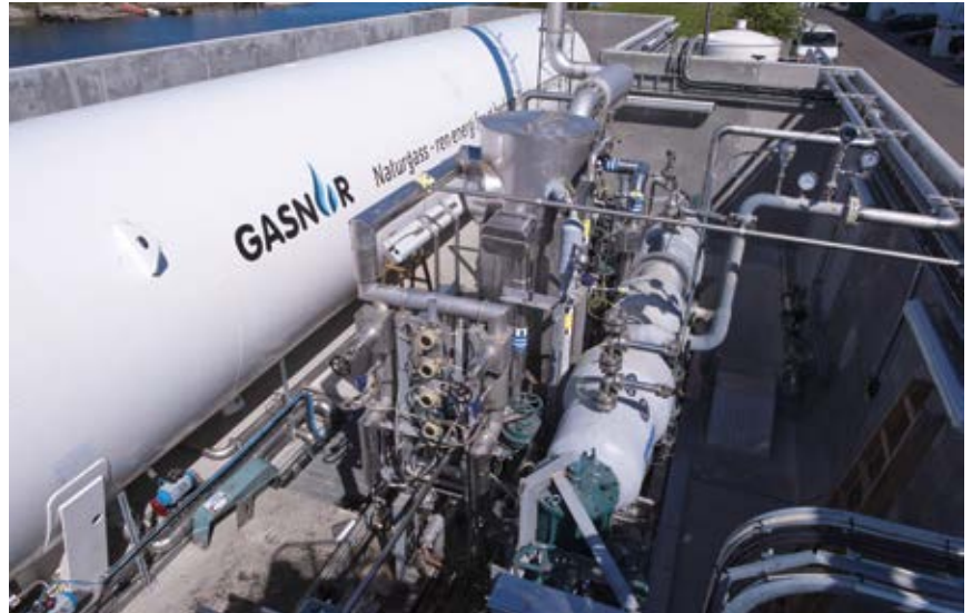
대우조선해양이 독자 개발한 고압천연가스 연료공급장치(FGSS)
