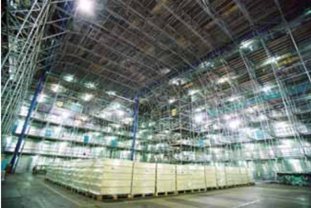
Construction inside the LNG carrier cargo tank
